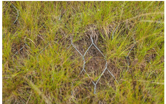
Bild 3 Die optimierte Maschen-Geometrie ermöglicht die Herstellung aus hochfestem Draht
